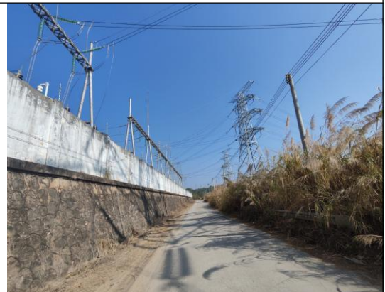
塔岭站东南侧
